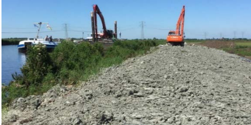
Toepassing van Granuliet in een boezemkade
