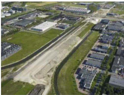
Granuliet gebruikt in de ophoging van Rijkswegen (A5 & A9)
