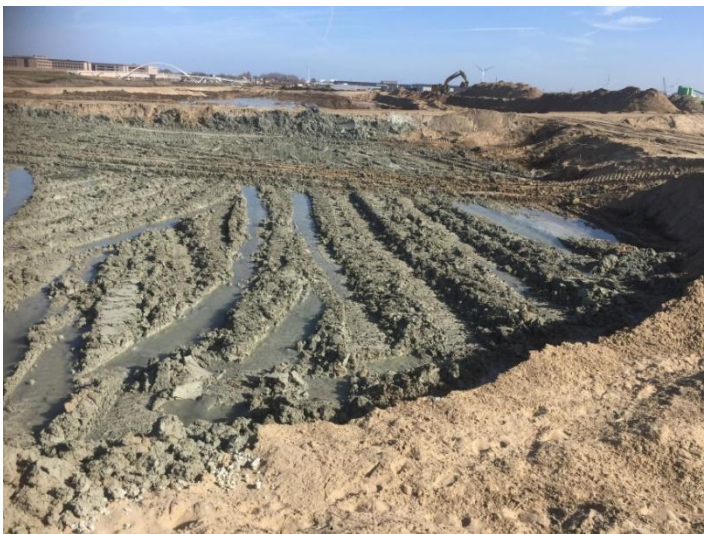
Figuur 4.4 Staand water op Noordse Leem in een terreinophoging: een omstandigheid die bij het verwerken van Noordse Leem te allen tijde vermeden moet worden, omdat de sterkte en samendrukbaarheid van Noordse Leem door een te hoog watergehalte verslechteren
