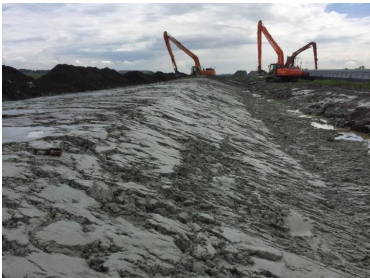
Figuur 2.2 Noordse Leem in een boezemkade (Hooivaart, Akkrum). Op de achtergrond de grond die voor het afdekken van de Noordse Leem wordt gebruikt
