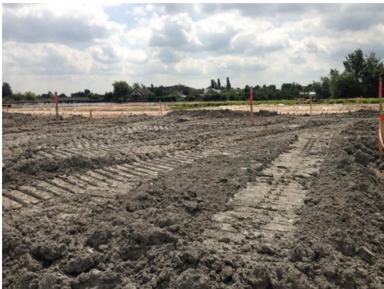
Figuur 2.3 Noordse Leem in een terreinophoging (Roelofarendsveen)
