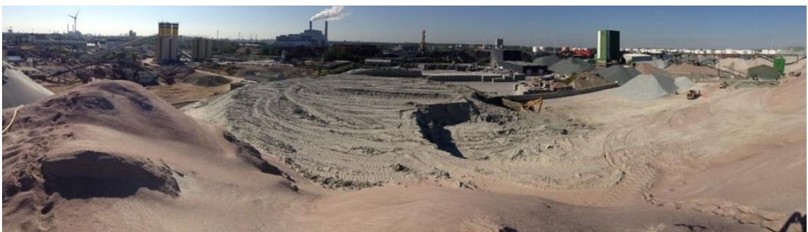
Figuur 2.1 Overzicht van het depot van Noordse Leem in de haven van Amsterdam, de hydraulische kraan geeft de schaal weer. Let op de steil afgegraven hoge wand in de Noordse Leem. Op de voorgrond zand van de brekerinstallaties
